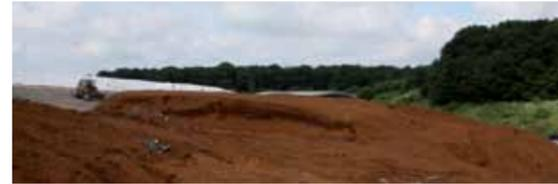
Deponierte Neutralisationsschlämme aus der Stahlindustrie
