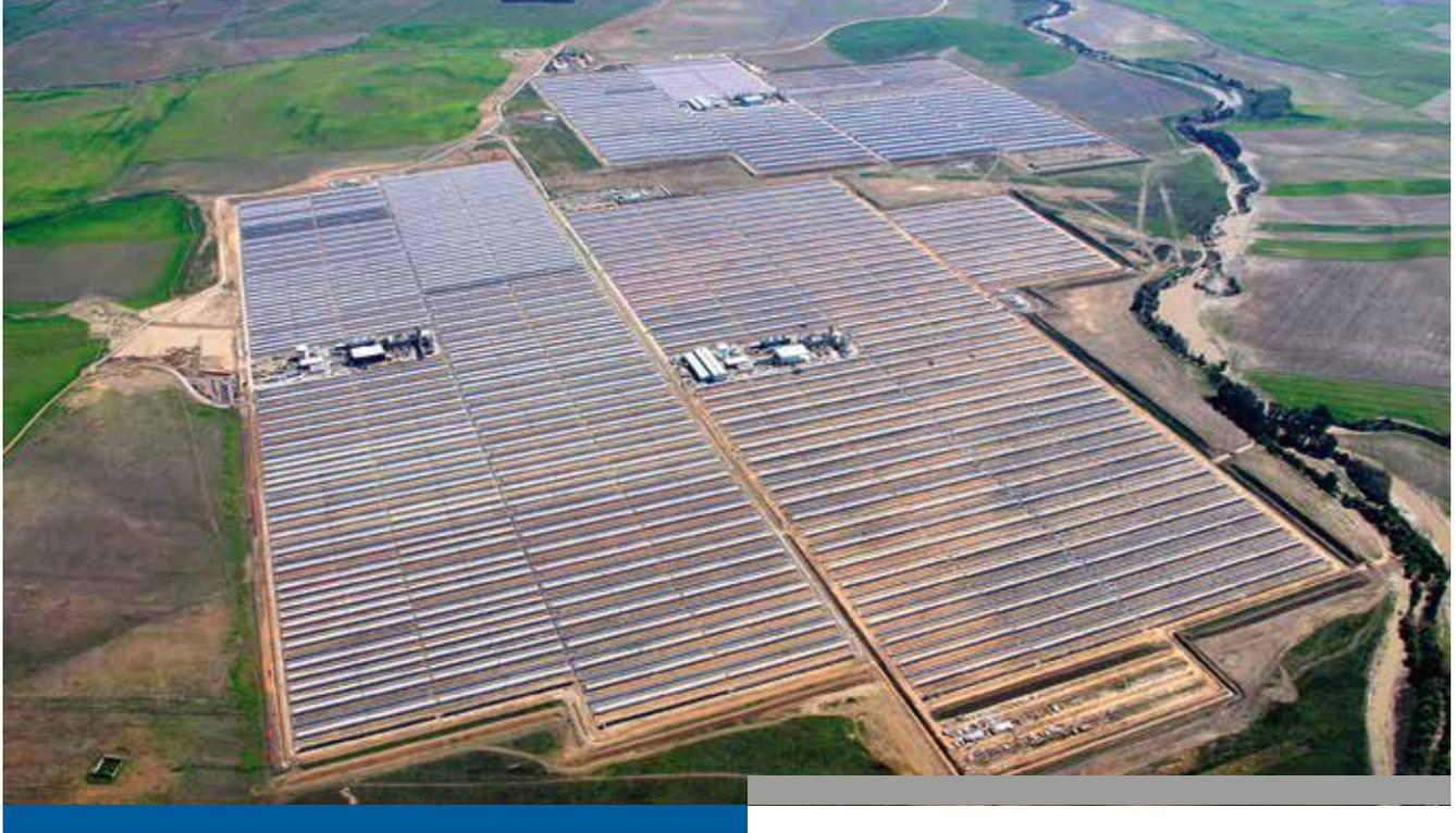
**POTENZIAL AUSSCHÖPFEN:** Gemeinsam mit Abengoa Solar, dem Betreiber dieser Parabolrinnen-Anlage bei Sevilla, arbeiten Materialforscher des HZDR daran, den Wirkungsgrad von thermischen Solarkraftwerken zu erhöhen. Foto: Abengoa Solar, S.A.
