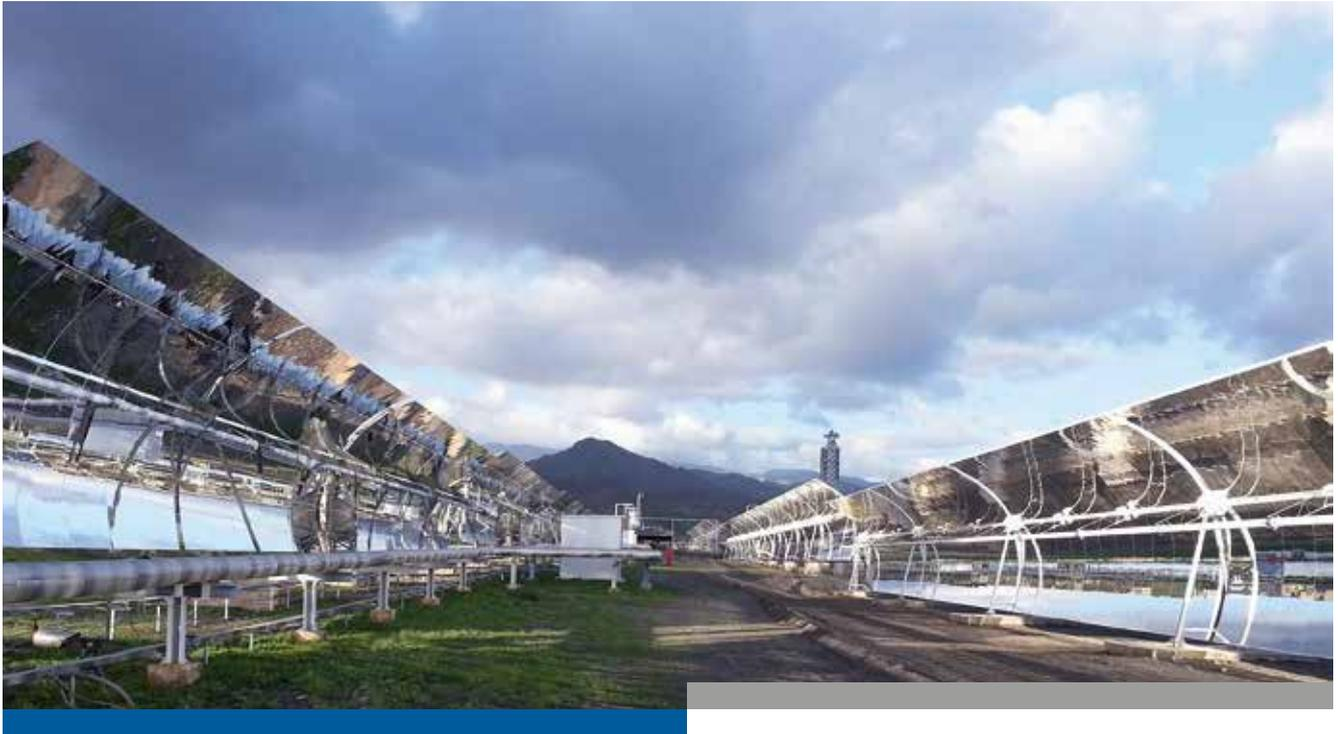
**OHNE VERLUSTE:** In der Testanlage DUKE wird Wasserdampf für die Stromgewinnung direkt in den Rohren der Parabolrinnen erzeugt. Damit entfallen spätere Zwischenschritte über Wärmeträger-Medien. Foto: DLR
