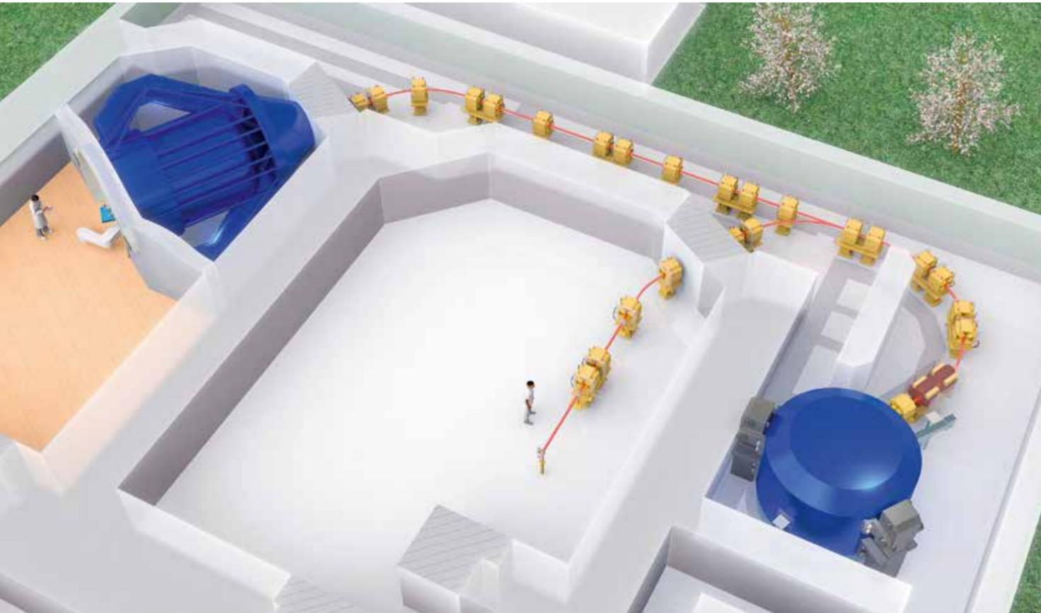
Als eine der wenigen Einrichtungen weltweit erlaubt das Nationale Zentrum für Strahlenforschung in der Onkologie - OncoRay nicht nur die Behandlung der Patienten in der Gantry (links), sondern auch Versuche mit den geladenen Teilchen in einem speziellen Experimentierraum (Mitte). Die Protonen werden mit einem Kreisbeschleuniger (rechts) erzeugt und über ein magnetgesteuertes Strahlführungssystem in die Räume transportiert. Quelle: OncoRay
