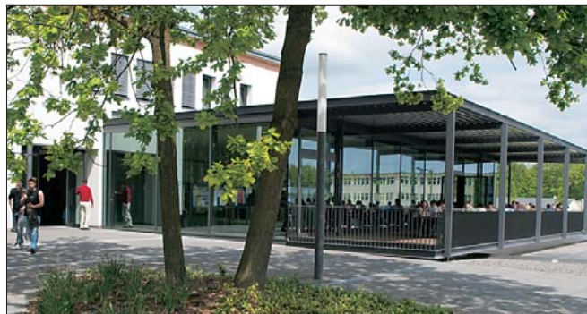
Die Erneuerung des Betriebrestaurants mit dem großen gläsernen Anbau samt Terrasse war Teil eines umfassenden Sanierungsplans am HZDR.
