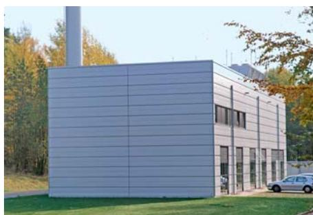
Durch den Neubau eines Blockheizkraftwerkes mitten auf dem Campus konnte das Nahwärmenetz verkürzt werden.
